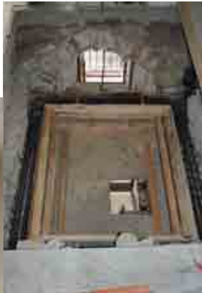
Blick in den Schacht des neu integrierten Aufzuges im Jägerhof
